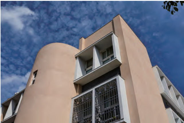
荊桐衛生所 設計 | 張涵璋建築師事務所 施工 | 坂茂綠能工程 產品 | 柚子肌 JP-100 T2028/T1000/T5400
