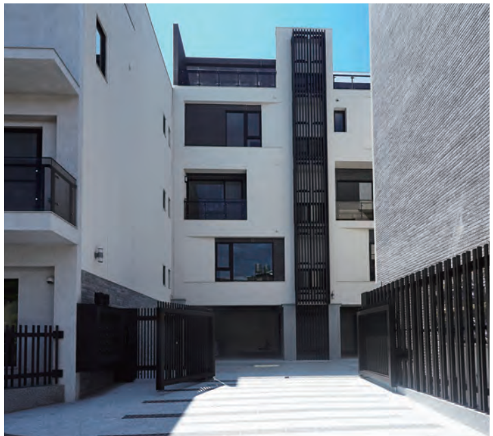
金鋹微豐墅・設計 | 林志成建築師事務所 施工 | 坂茂綠能工程 產品 | 小粒岩石S(特製2) JQ-500 T1703
